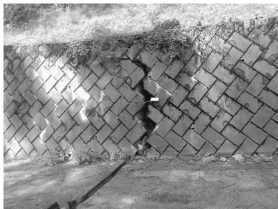
▲写真② ブロック積みの亀裂
