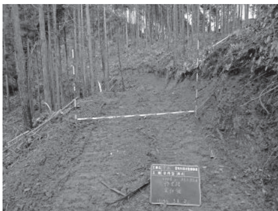
▲作業路作設風景（上） 完了後（下）
