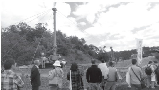
▲写真⑤ 実習で使用しているものより、かなり大きなタワーヤーダでした
