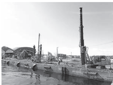
▲写真② 漁港岸壁の液状化対策
