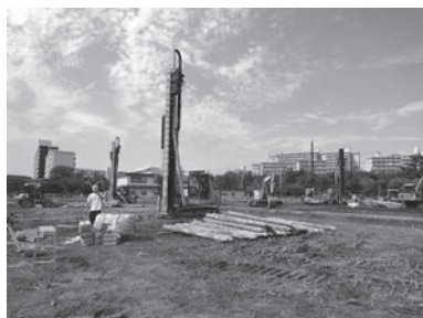
▲写真① 大規模戸建分譲住宅開発地の液状化対策
