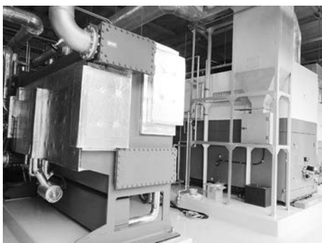
▲写真① 吸収式冷凍機 (左) (冷房用冷水発生器)
