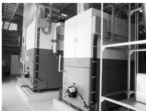
▲写真② 木質バイオマスボイラー（500kW + 200kW）
