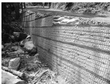
▲写真② 補強盛土工法を採用した 基幹作業道
