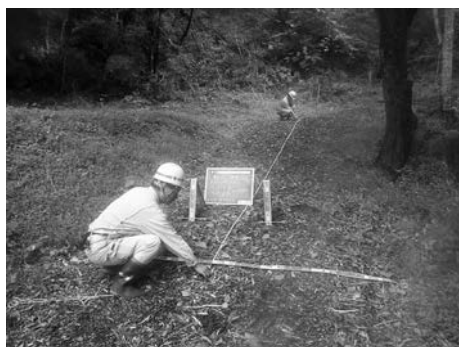
▲写真④ チップ容積の確認（施工出来形確認）
