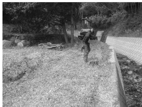
▲写真③ チップの敷設処理
