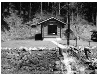
▲写真③ 治山堰堤から取水した水で発電する群馬県利平茶屋水力発電所
