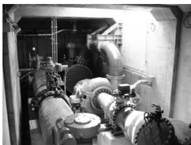
▲写真① 神奈川県港北発電所 左側に水道本管が配置されており、並行して右側に水道発電の水压管路（水道バイパス管を活用）及び水車発電機が配置されている。
