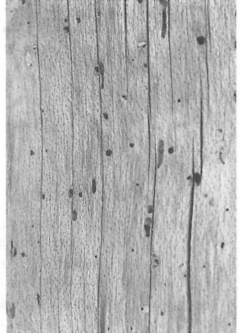
写真⑥ 立石寺根本中堂の柱の虫穴。材面の斑点が椋目
