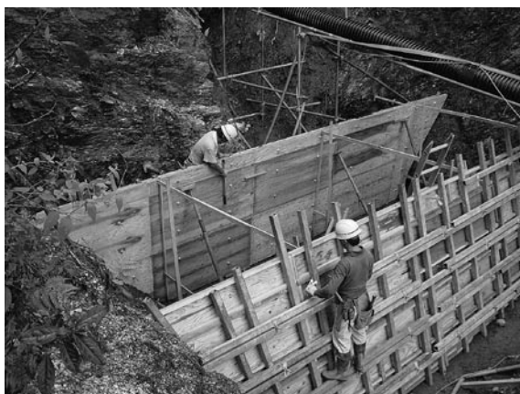
▲写真③ 間伐合板を使用した型枠施工事例
