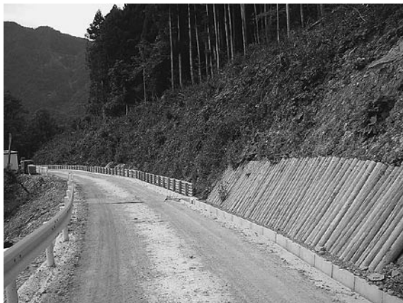
▲写真② 林道事業における間伐材使用事例
