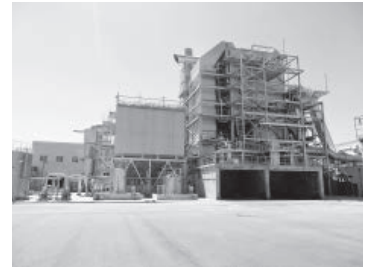
▲写真④ 日向工場の木質バイオマス発電設備
