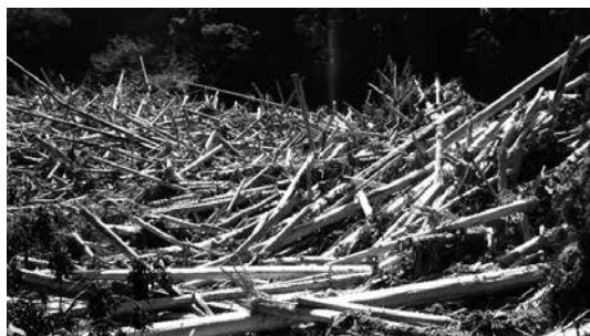
▲写真⑧ 不透過型コンクリート砂防堰堤による流木捕捉状況（福岡県朝倉市，妙見川，2017年7月）
