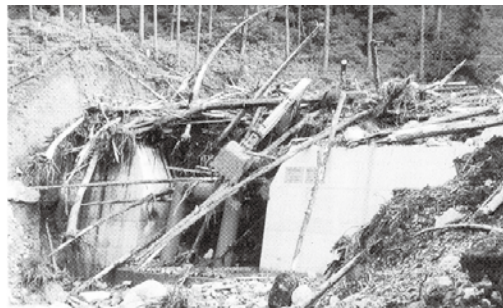
▲写真② 鋼製スリット型構造物による流木・土砂の捕捉（大分県，熊戸川，1992年）
