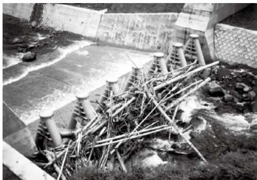
▲写真③ 鋼製スリット型構造物による流木・土砂の捕捉（福岡県うきは市，持木川，1995年5月）
