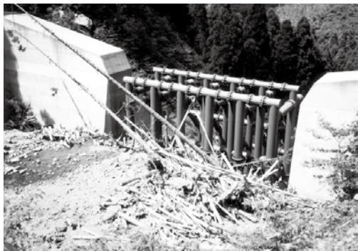
▲写真① 鋼製スリット型構造物による流木・土砂の捕捉（福岡県久留米市，冷水川，1995年5月）
