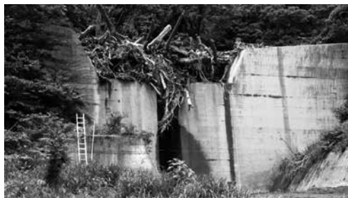
▲写真⑦ コンクリートスリット型堰堤による流木捕捉 (長野県飯山市, 2017 年 5 月)
