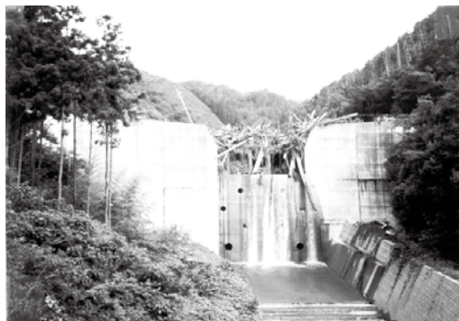
▲写真④ 部分スリット型構造物による流木捕捉（広島県，荒谷川，1999年6月）
