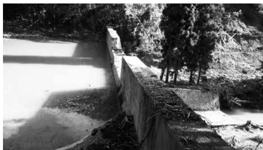
▲写真⑨ 捕捉された流木の除去後の状況，満砂していない（福岡県朝倉市，妙見川，2017年12月）
