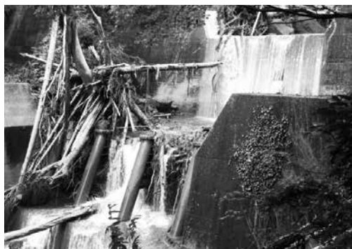
▲写真⑥ 副ダムに設置された鋼製スリット型構造物 による流木捕捉 (熊本県阿蘇市, 2012 年 7 月)
