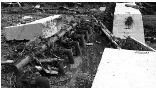
▲写真⑤ 堆砂地内に設置された鋼製スリット型構造物 (福岡県, 赤谷川左支川汐入川, 2017 年 7 月)
