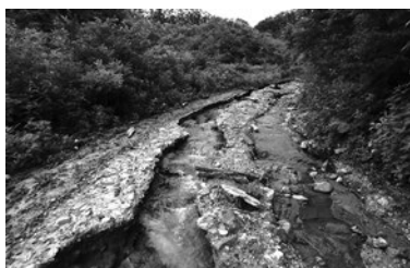
▲写真④ 被災状況／近隣林道 左から路面洗掘，路体決壊
