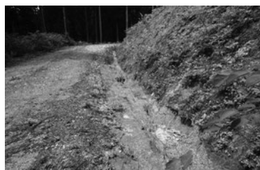
▲写真① 被災状況／伊西3号線 左から管渠の閉塞，横断排水呑口の埋没，側溝の浸食
