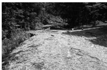
▲写真③ 被災状況／滝ヶ洞口線 左から流木が管渠上部に堆積，路面流下跡
