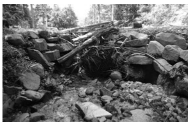
▲写真③ 被災状況／滝ヶ洞口線 左から流木が管渠上部に堆積，路面流下跡
