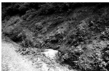
▲写真① 被災状況／伊西3号線 左から管渠の閉塞，横断排水呑口の埋没，側溝の浸食
