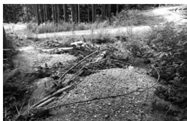
▲写真① 被災状況／伊西3号線 左から管渠の閉塞，横断排水呑口の埋没，側溝の浸食
