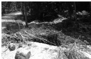
▲写真② 被災状況／滝ヶ洞口線 左から管渠の閉塞，側溝の浸食，側溝の浸食
