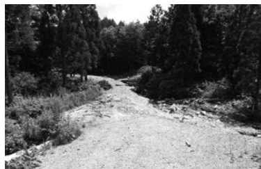
▲写真② 被災状況／滝ヶ洞口線 左から管渠の閉塞，側溝の浸食，側溝の浸食
