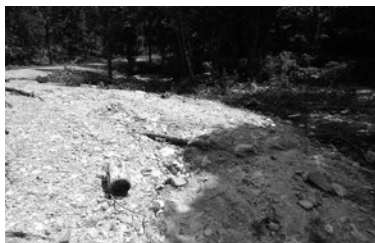
▲写真② 被災状況／滝ヶ洞口線 左から管渠の閉塞，側溝の浸食，側溝の浸食
