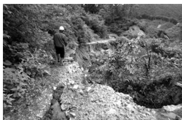
▲写真④ 被災状況／近隣林道 左から路面洗掘，路体決壊
