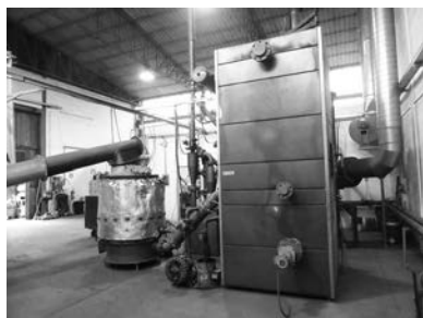
▲写真⑪ Dislpnseri 社の施設内。 Holzenergie 社のガス化炉（左）と ガスフィルター（右）
