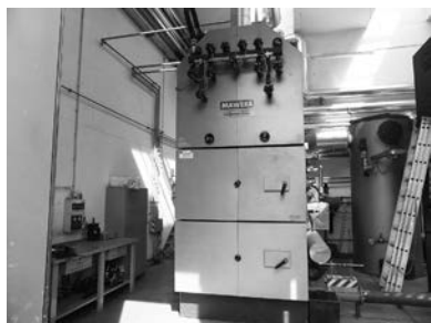
▲写真③ Mawera社(ドイツ)の0.8MWthボイラ
