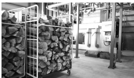
▲写真① 「エコタウン」融雪用薪ボイラー
