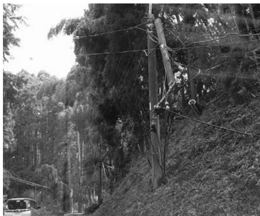
▲写真① 2019年台風15号の風倒木が電柱を損壊した事例
