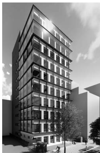
図① 地上11階建ての純木造高層耐火建築物の完成予想図
