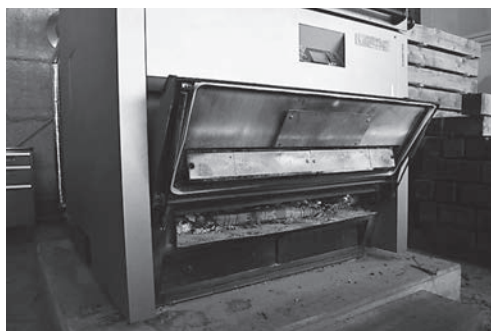
▲写真② 薪ボイラー (フィースマン、オーストリア製)
