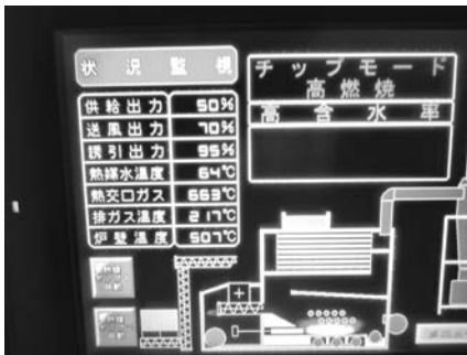
▲写真① チップモードでの高含水率モードでのボイラー状況監視モニター
