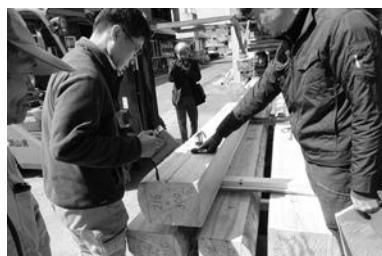
▲写真⑩ 含水率の計測
