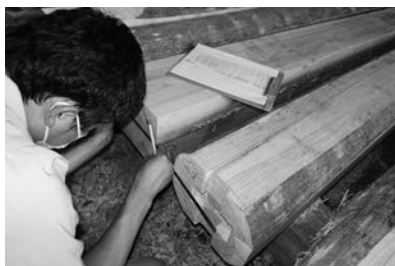
▲写真⑮ 十字目違い継手の計測
