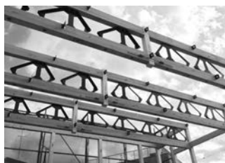
▲◀写真① 自動車整備工場の 建築に用いた 「STT-system」 三角形金物の高さ 490mm、上下の梁 成各 210mm、スパン 9.1m で使用。
