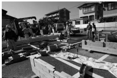
▲写真① 竹下棟梁の指導のもとで試験体を製作
