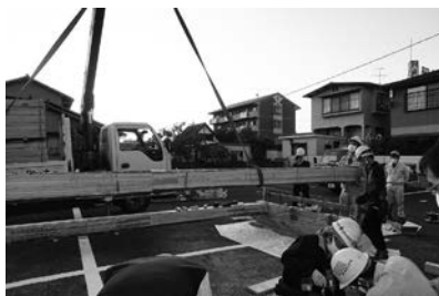
▲写真③ 岡山県新見市産ヒノキ2本継手タイプの製作
