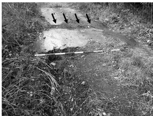
▲図② 閉塞した横断排水溝（写真奥の矢印）と閉塞が原因と思われる路面侵食
