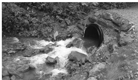
▶写真② 生態系配慮型 暗渠工 （滝ヶ洞線）
