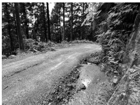
▲写真① 作業道の水処理
