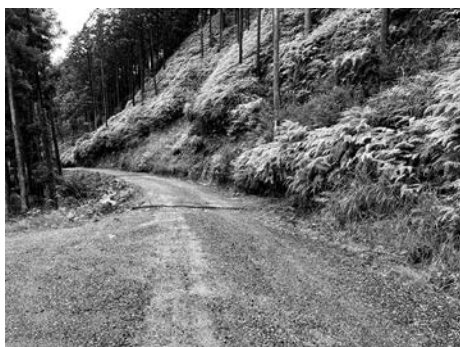
▲写真① 作業道の水処理
