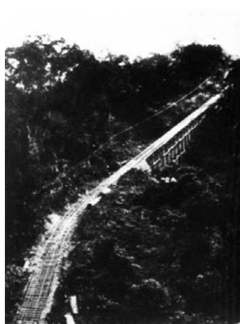
◀写真① 第3インクラインの軌道 向かって右側の軌道が林産物の搬出用、左側が空車の逆送用に使用されていた。
