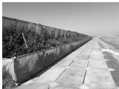
▲海側から見た、施工 6 年後の緑の防潮堤試験区（2019 年 10 月 1 日、岩沼市）
