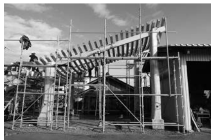
▲写真⑫ 全ての湾曲積層梁の設置が完了
