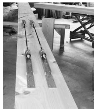
▲写真⑧ 桁材の十字目違い継手と接合金物
