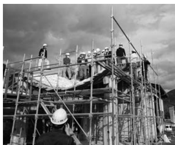
▲写真⑬ 積載荷重試験の様子
