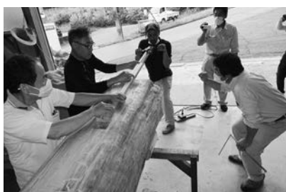
▲写真⑥ キリでアンカーボルト穴を開ける
