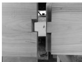
▲写真⑧ 桁材の十字目違い継手と接合金物
