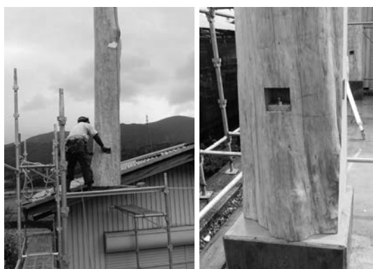
▲写真⑨ ヒノキ丸太柱の設置
