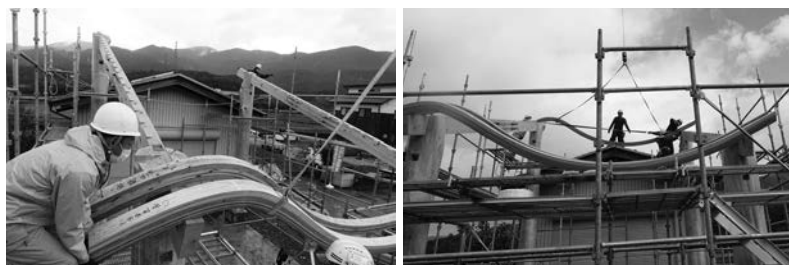
▲写真⑪ 湾曲積層梁設置の最初の工程
