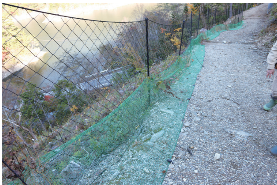
▲写真③ 面的防護資材による防護の事例 (四国森林管理局森林技術・支援センター試験地で撮影)
